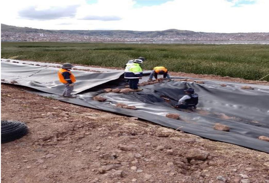
Imagen 8. Instalación de la geomembrana para los humedales artificiales.
