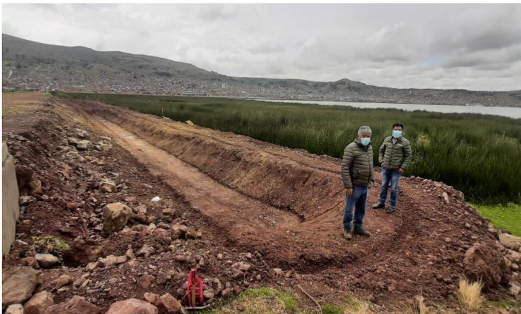
*Imagen 7. Retiro de elementos cortantes y excavación de zanja para borde de geomembrana (superficie de apoyo).*
