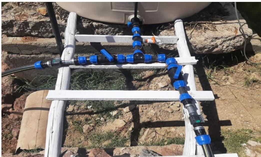
Imagen 13. Se instaló un tren de descarga del fluido para abastecer a ambos humedales.
