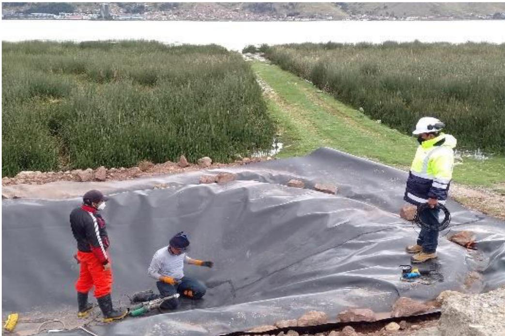
Imagen 9. Se colocó la geomembrana en toda la dimensión de la poza, con equipos de termofusión y extrusión.
