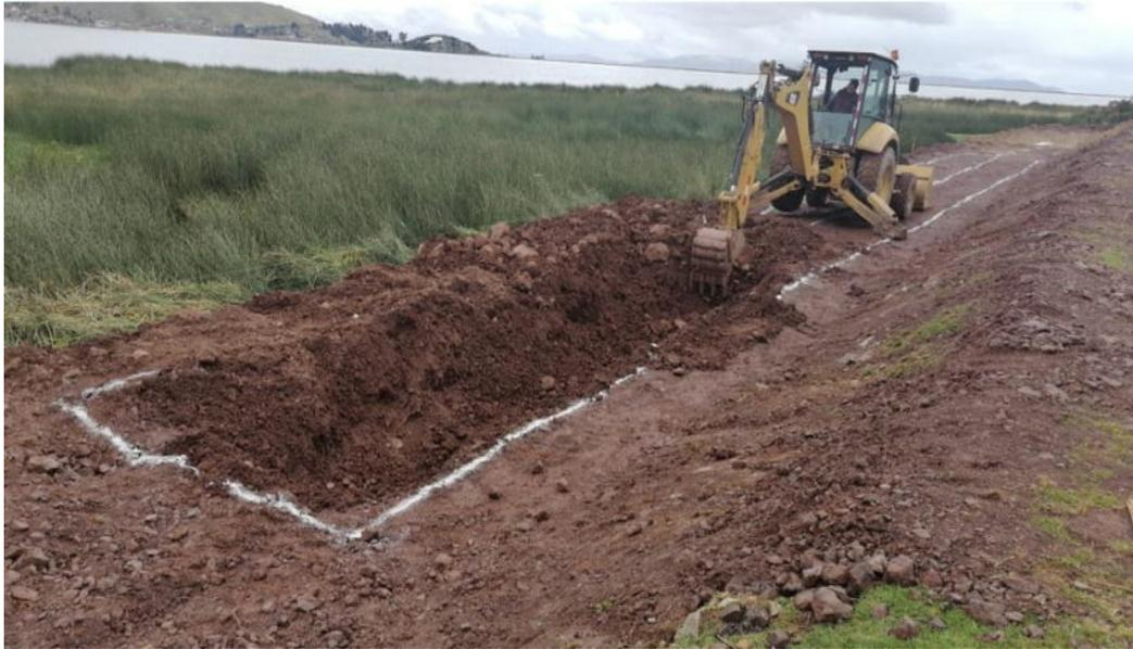
*Imagen 4. Trazo y excavación para los humedales.*
