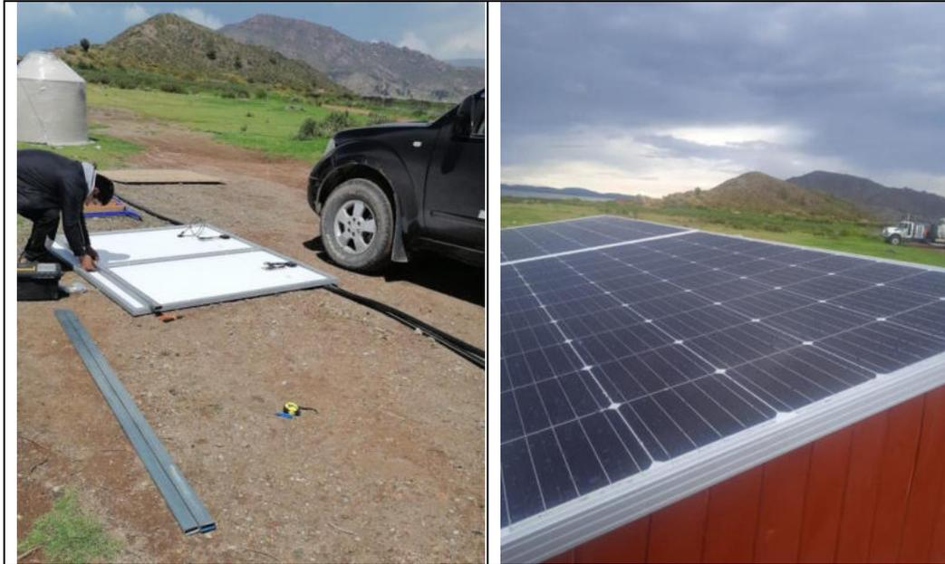
Imagen 18. El sistema solar se instaló sobre el techo de la caseta-oficina.
