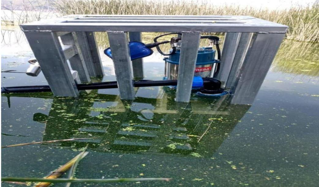
Imagen 10. La instalación de la bomba se realiza en la orilla del Lago Titicaca a una profundidad de 1.3 m.
