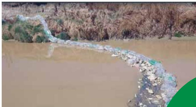
Biobarda instalada en el río Pallina, capturando varias toneladas de botellas plásticas.
