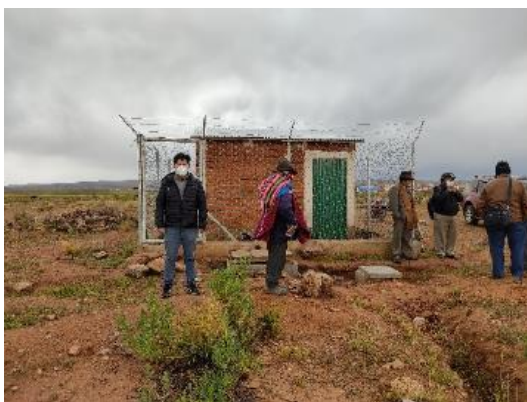
Caceta de bombeo para riego
